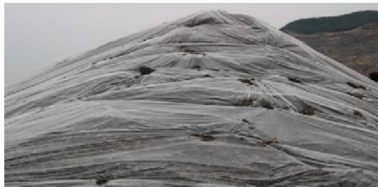
图 9.12 土方破碎后加水闷料
