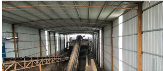
图 9.9 全封闭彩钢瓦结构
