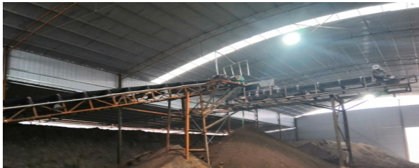
图 9.10 安装喷淋设施
