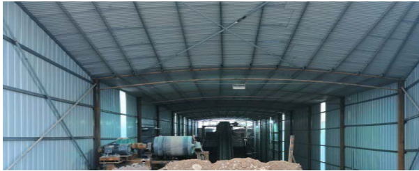
图 9.8 全封闭彩钢瓦结构
