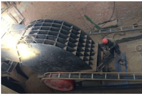
图 9.2 调试碎石破碎装置
