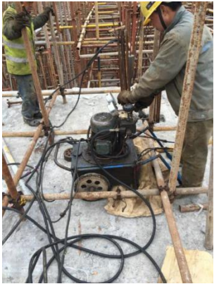
图 9-4 维保后的设备进行现场施工
