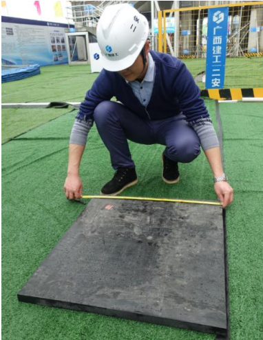
照片 29 橡胶板切割尺寸检验
