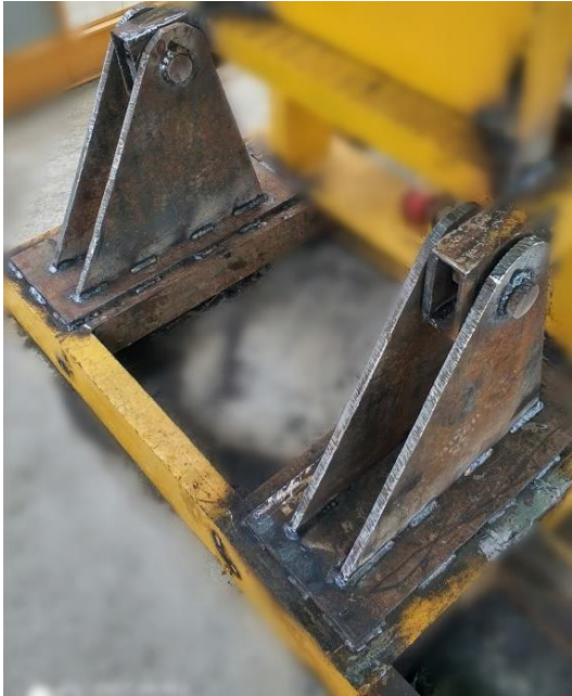
照片 15 带轴套的销轴铰支座安装完成后 拍摄人：覃正华 拍摄时间：2018 年 10 月 25 日
