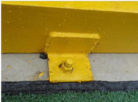
照片 18 膨胀螺栓安装完成
