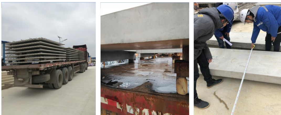
照片 6 PC 墙板构件进场检验
