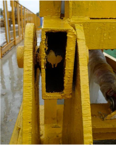
照片 24 托举平台与铰支座连接处涂抹黄油后 拍摄人：王立诚 拍摄时间：2018 年 11 月 5 日
