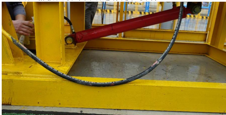
照片 20 液压顶升装置安装完成
