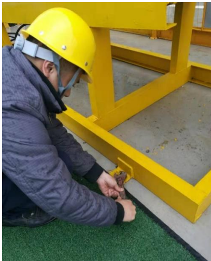
照片 17 膨胀螺栓安装
