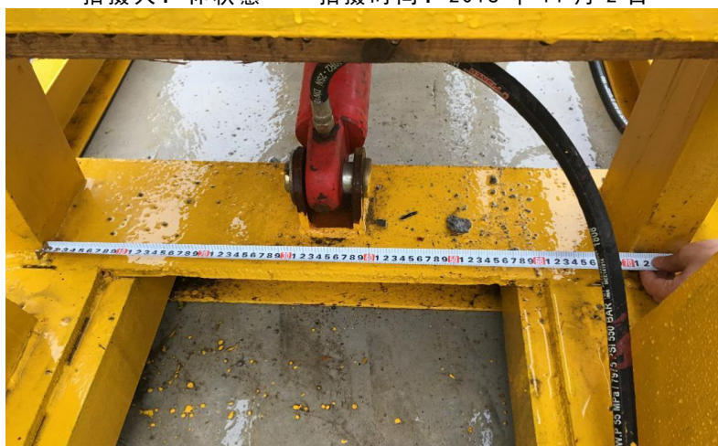
照片 22 液压缸安装位置检查 拍摄人：林秋蕙 拍摄时间：2018年11月2日
