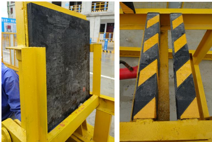
照片 31 防撞橡胶垫安装效果
