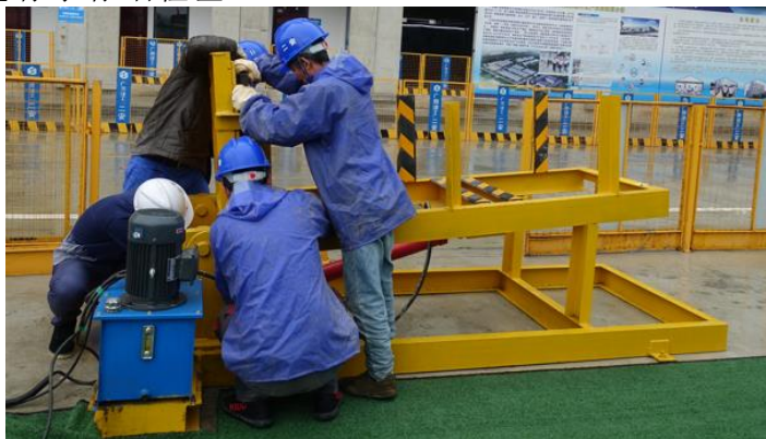
照片 32 PC 柱侧立架整体检验
