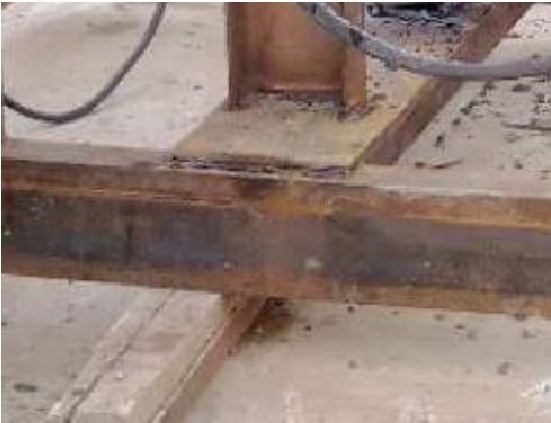
照片 12 枕木铺垫在槽钢下方
