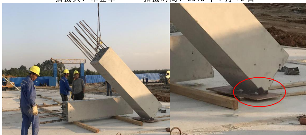
照片 2 PC 柱翻起至直立起吊
