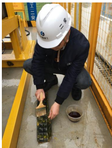
照片 30 橡胶板切割尺寸检验
