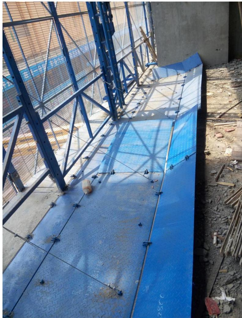
1、加长件型号为两根16#槽钢,其在X-X方向截面模量为 $2 \times 117 \times 10^3 \text{mm}^3$ ,强度为215Mpa,受力情况验算如下: √
