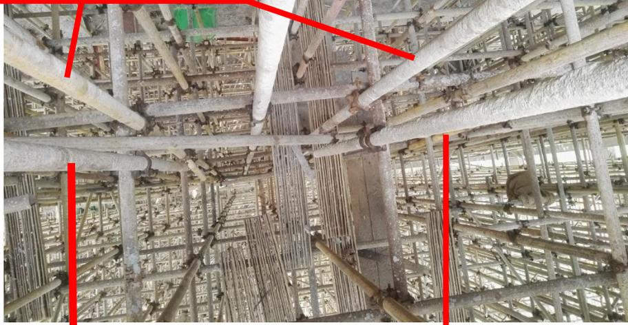
梁底设计两根立杆，实际只有1根。后加1根立杆2.5m长没有落地，其轴向力转移给单根立杆，十分危险！
