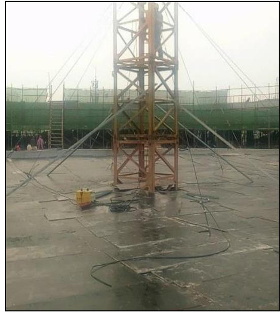
图 7-16 覆面材料敷设完成
