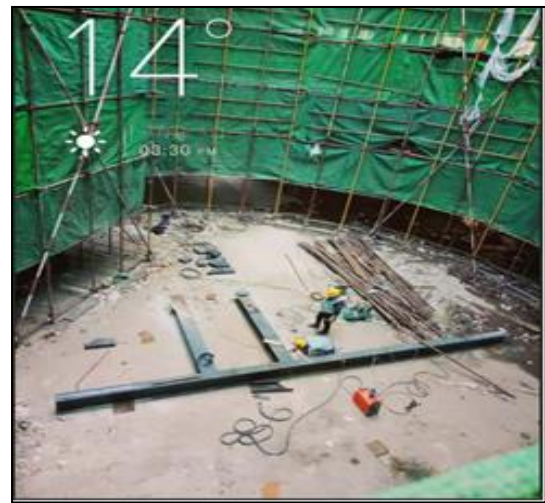
图 7-2 工字钢焊制图
