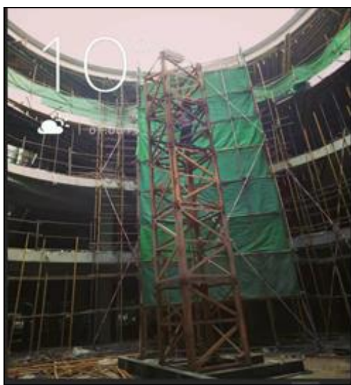
图 7-3 塔吊标准节安装过程图
