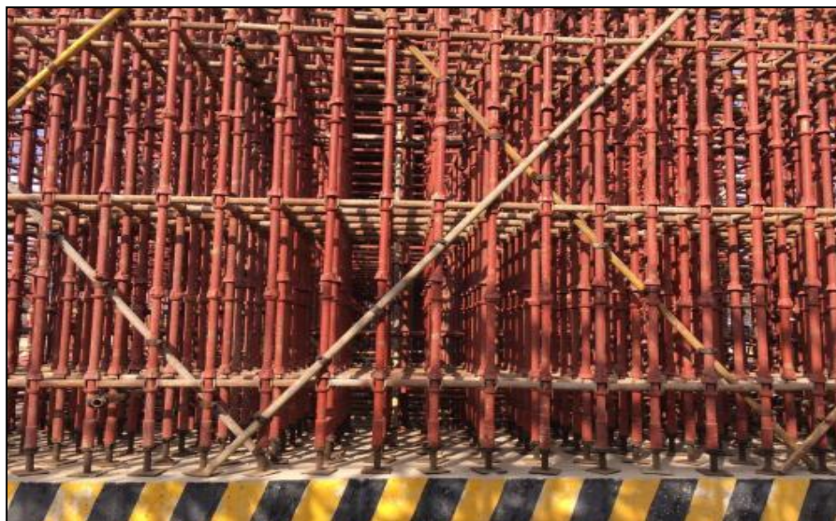
图 3-1 满堂脚手架
