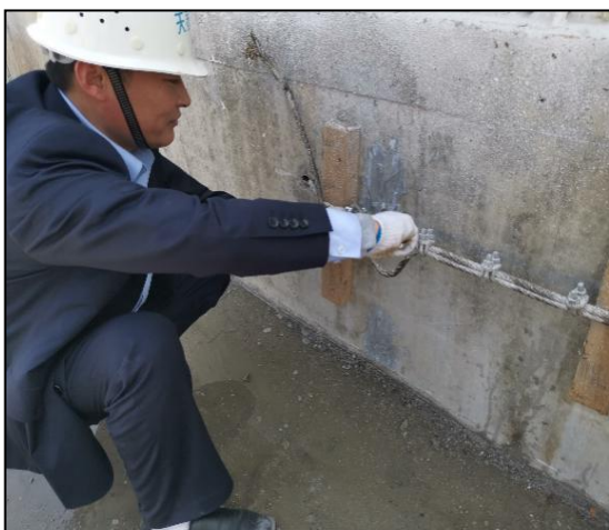
图 7-9 钢丝绳固定卡扣紧固
