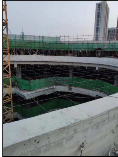
图 7-12 拉结钢丝绳设置
