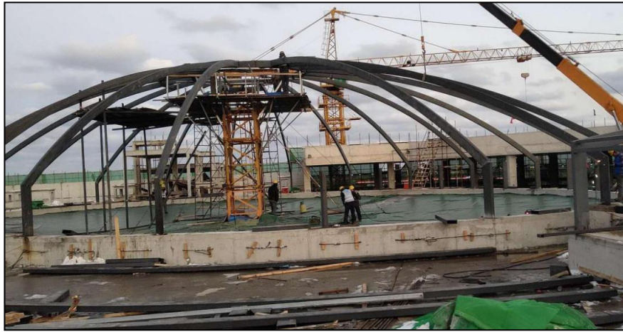
图 8-1 采光顶钢构件安装图
