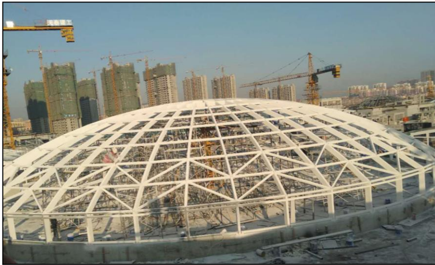
图 8-2 采光顶骨架安装完成图
