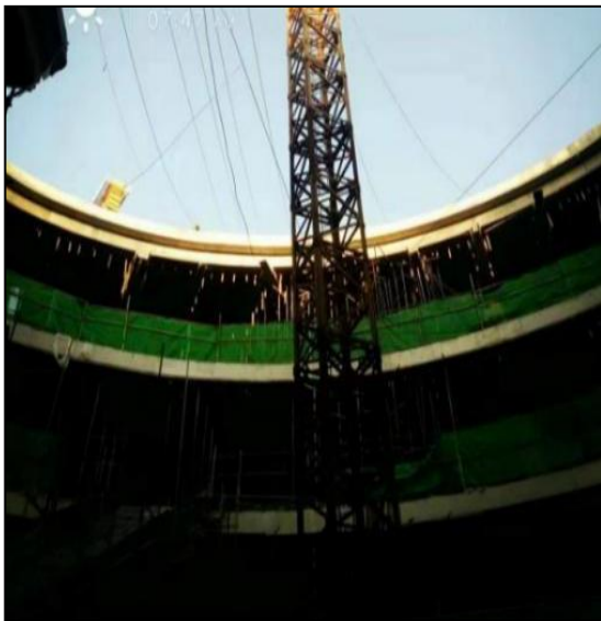
图 7-7 短轴方向钢丝绳设置
