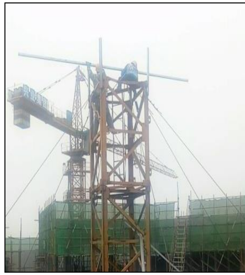
图 7-6 槽钢焊制安装
