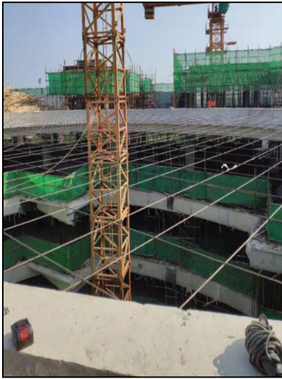
图 7-11 拉结钢丝绳设置
