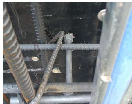
图 8-12 “通过双螺母将螺栓固定在模板上” 试验
