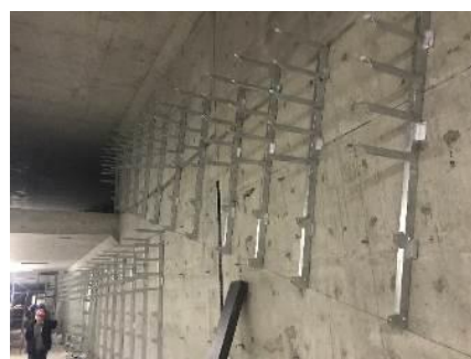
图 1-5 二层支管廊电力支架布置照片
