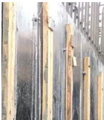
图 8-9 “先支模后定位钻孔”试验
