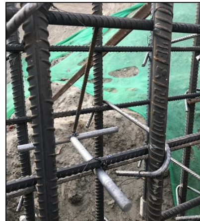
图 7-9 T 型螺栓现场固定形式
