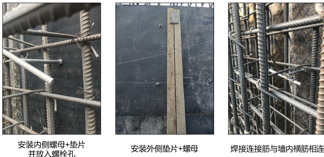
图 9-11 现场演示 T 型螺栓固定形式
