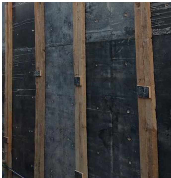
图 9-5 对策实施后螺栓孔位置情况
