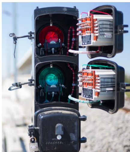
图 6 铁路信号机及信号线把示意图
