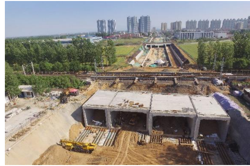
图 55 现场施工顶推资料
