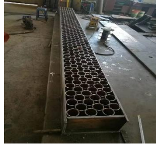
图 73 焊接完成的分配梁
