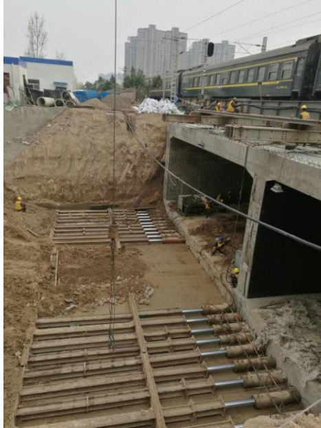
图 54 现场施工顶推资料
