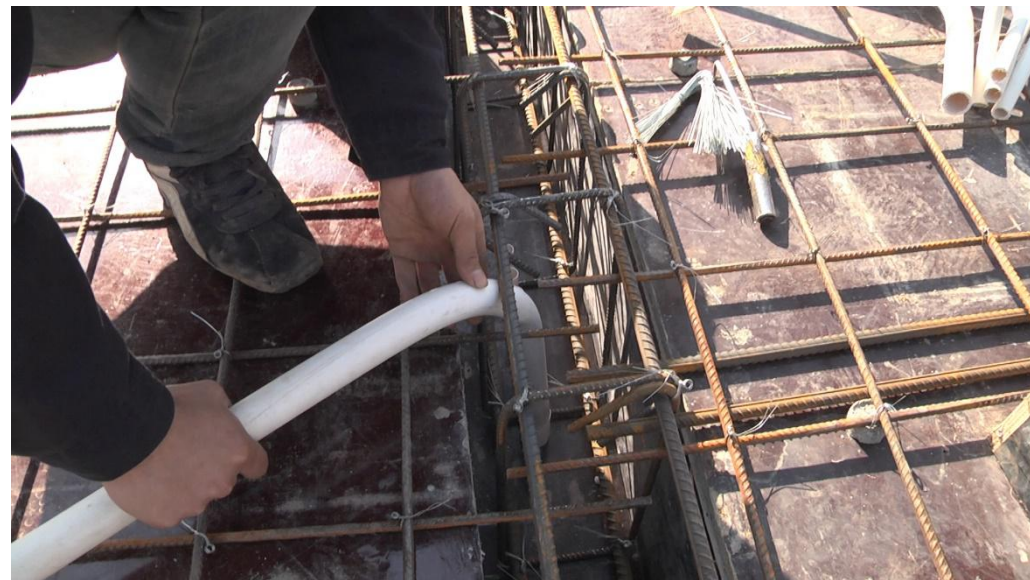
将线管插入套管中固定
