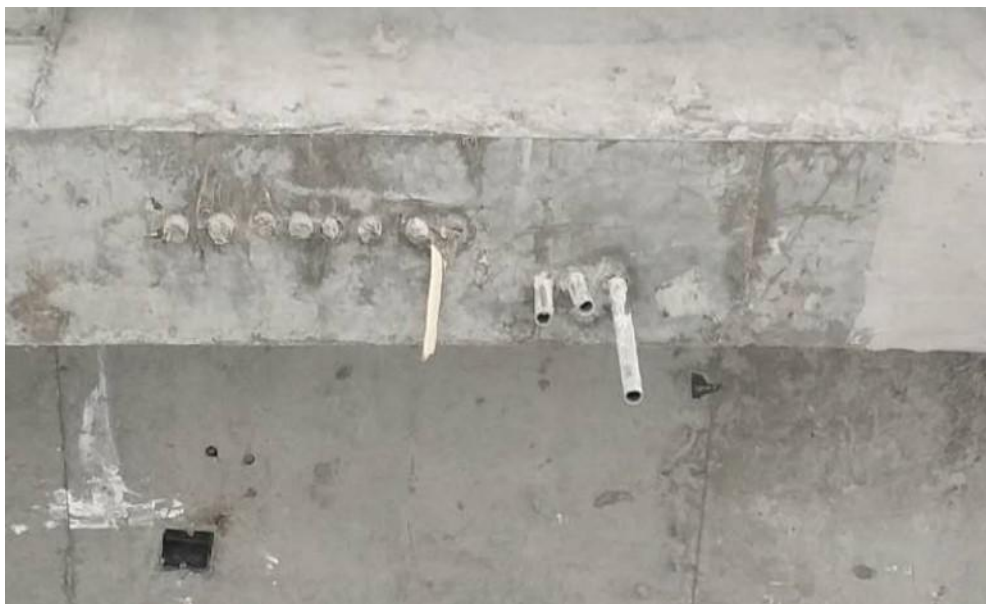
传统工艺拆模后梁底照片
