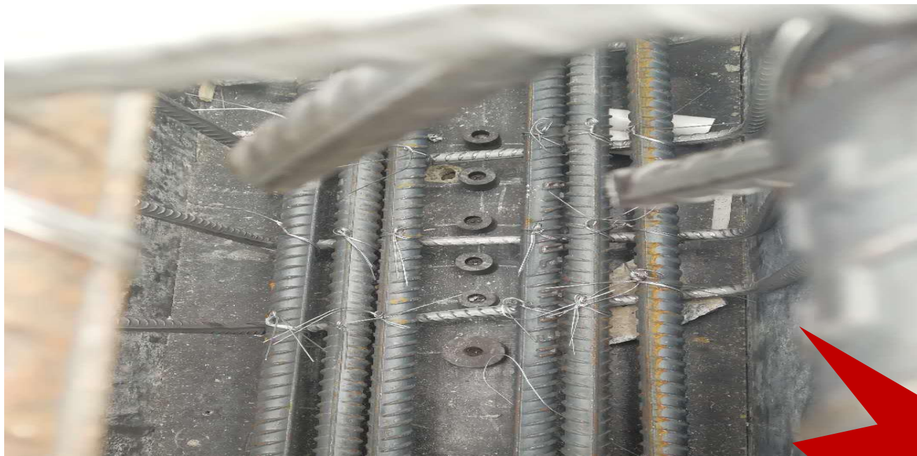
小组成员现场检查模具位移情况
