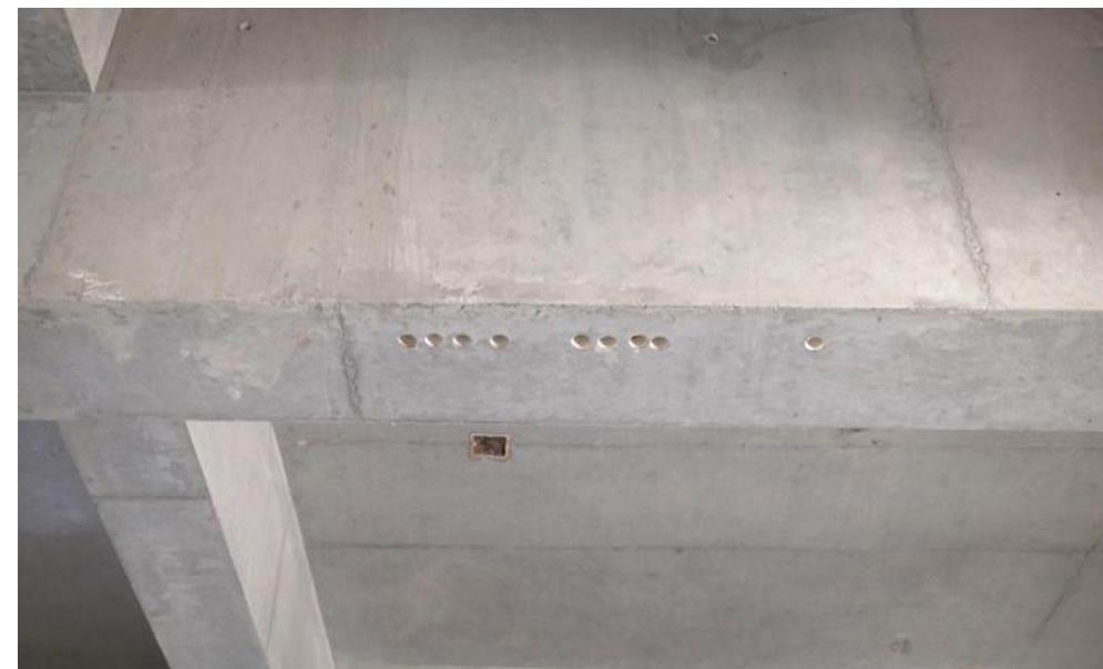
新施工方法拆模后梁底照片
