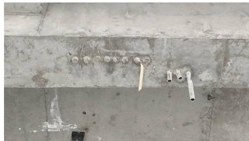
管孔处封堵不严，在梁底产生的漏浆
