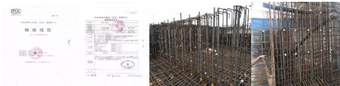
混凝土垫块强度合格和不合格对钢筋模板间距调查表
