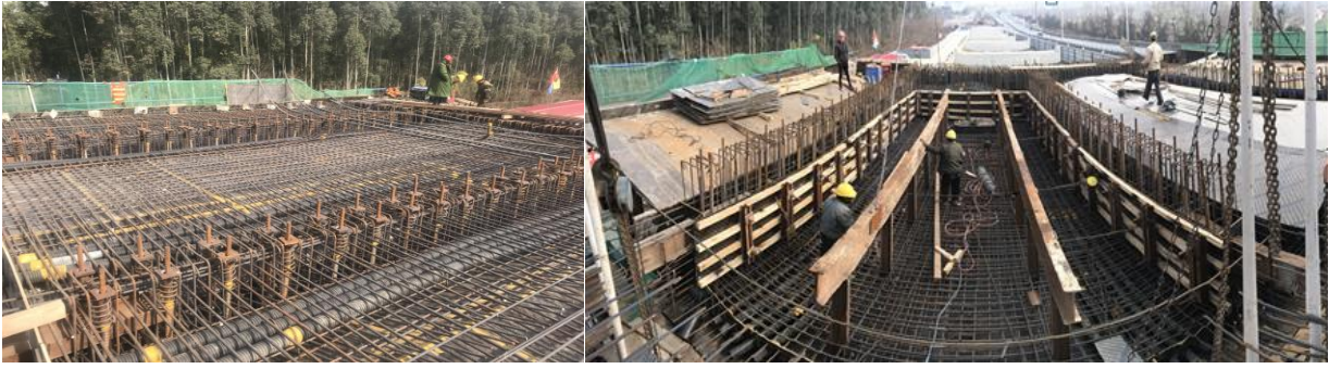
悬灌梁腹板钢筋模板间距定位合格率
