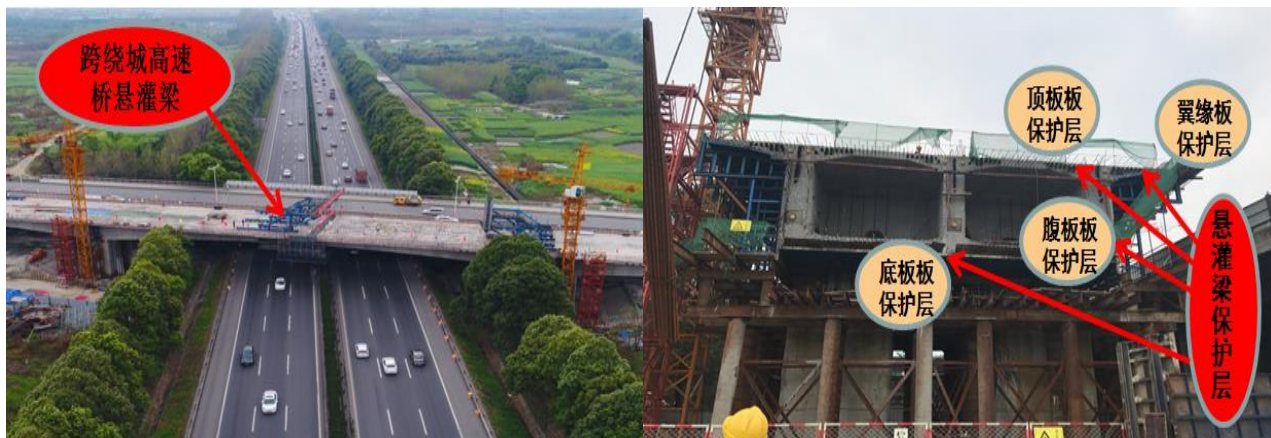
悬灌梁位置现场照片（实景）
